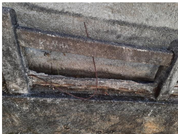
Figura 5 – Guarda-corpo com ferragem aparente
